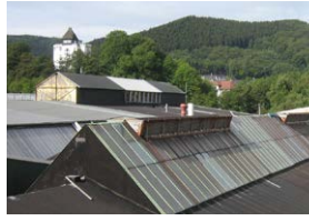
Pasma szedowe ze szkła zbrojonego drutem przed renowacją
